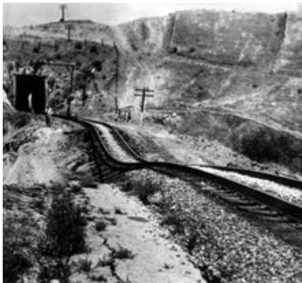
Daños provocados por los terremotos
