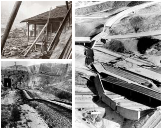
Daños provocados por los terremotos
