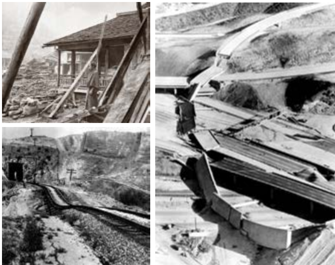
Daños provocados por los terremotos
