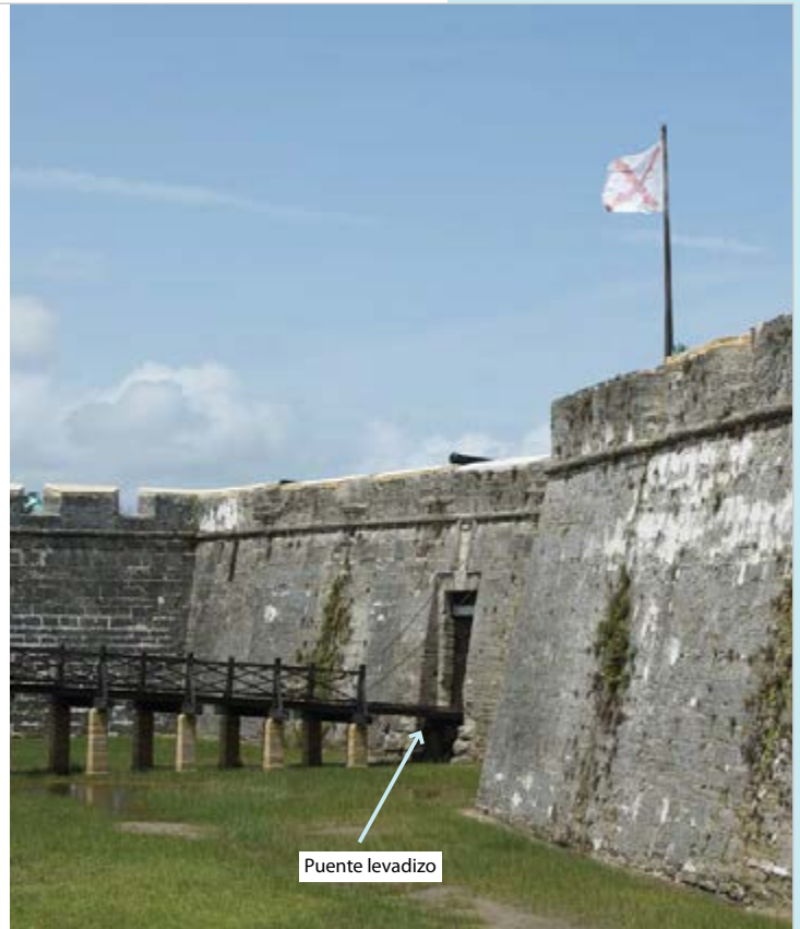
El puente levadizo que unía el revellín con la fortaleza principal
